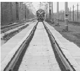
Рис. 41. Пенополистирол при строительстве железных дорог
