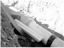
Рис. 49. Теплоизоляция трубопровода
