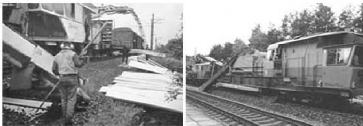
Рис. 43. Реконструкция железнодорожного полотна с помощью машины РМ-80 с применением плит ПЕНОПЛЭКС 45
