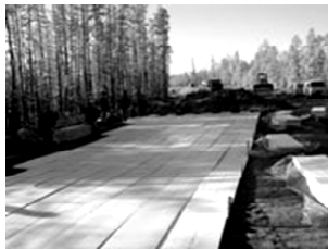
Рис. 37. Использование плит ПЕНОПЛЭКС при строительстве дорог
