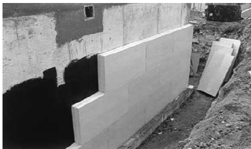
Рис. 51. Теплоизоляция фундамента
