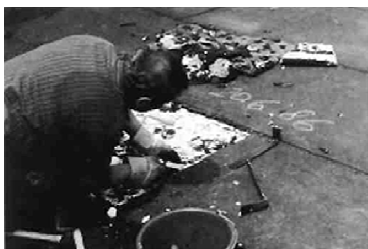
Рис. 52. Удаление покрытия крыши для изучения состояния панелей из пенопласта, установленных 31 год назад (а); образец, взятый с плоской крыши (б)
