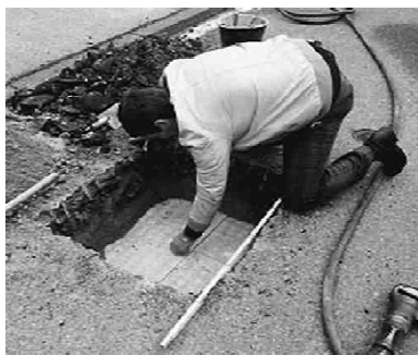
Рис. 53. Панель из пенопласта для защиты от промерзания при дорожном строительстве.
