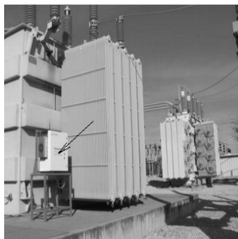
Рис. 2.23. Блок системы измерения влажности изоляции трансформатора TRANSFIX
