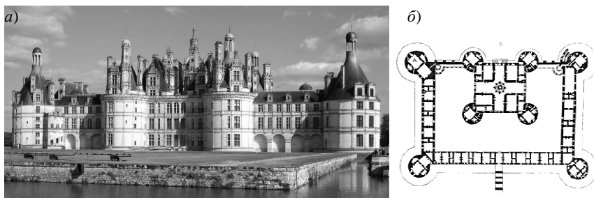
Рис. 44. Замок Шамбор в долине Луары во Франции (1519 – 1547 гг.): a – общий вид; б – план
