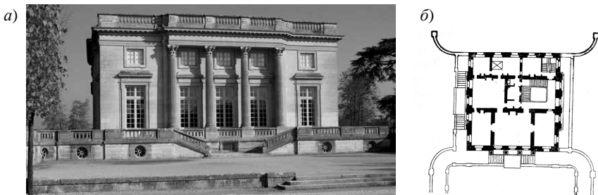
Рис. 55. Дворец Малый Трианон в Версале (1762 – 1768 гг.), арх. А.Ж. Габриэль: а – общий вид; б – план
