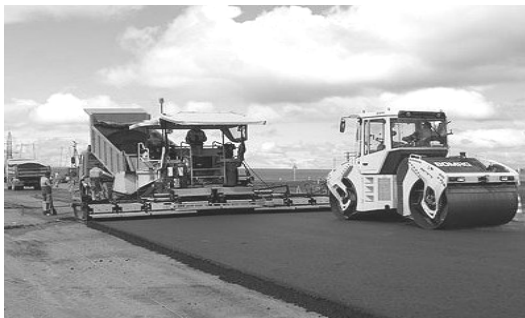
Рис. 4.1. Технологический процесс строительства покрытия нежесткого типа
