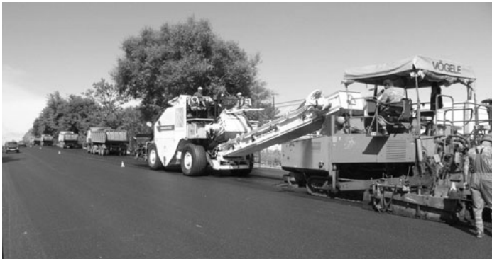
Рис. 4.14. Применение перегрузчика горячей асфальтобетонной смеси «Шаттл-Багги» для устройства дорожного покрытия
