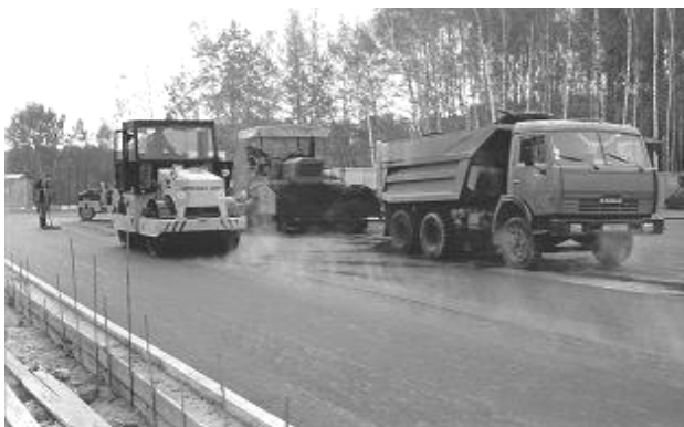
Рис. 5.50. Укладка асфальтобетонной смеси одним асфальтоукладчиком со смещением полос дорожного покрытия
