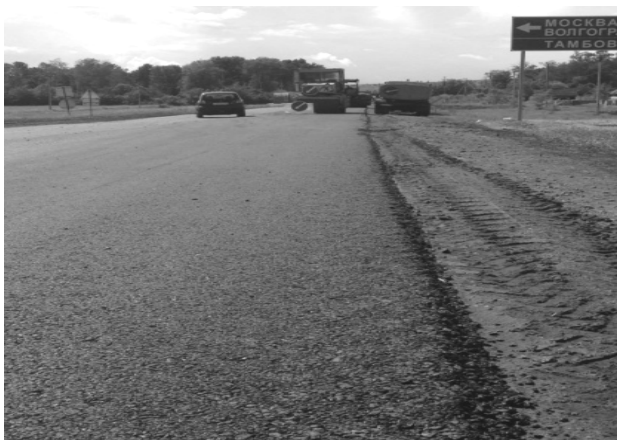
Рис. 5.29. Строительство дорожного покрытия автомобильной дороги «Тамбов–Воронеж»
