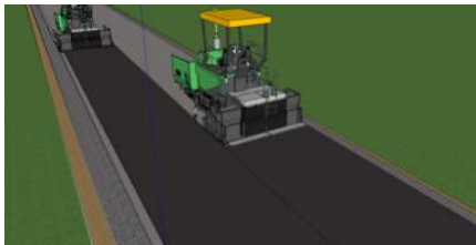
Рис. 5.8. Укладка асфальтобетонной смеси двумя асфальтоукладчиками
