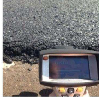
Рис. 5.16. Съемка тепловизионной камерой температуры асфальтобетона при устройстве покрытия
