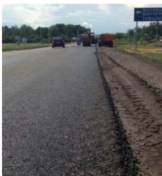
Рис. 6.22. Строительство дорожного покрытия автомобильной дороги «Тамбов – Воронеж»
