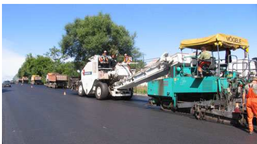
Рис. 5.2. Применение перегрузчика горячей асфальтобетонной смеси Shuttle Buggy для устройства дорожного покрытия
