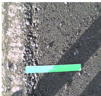
Рис. 6.23. Укладка новой полосы покрытия с ранее уложенной
