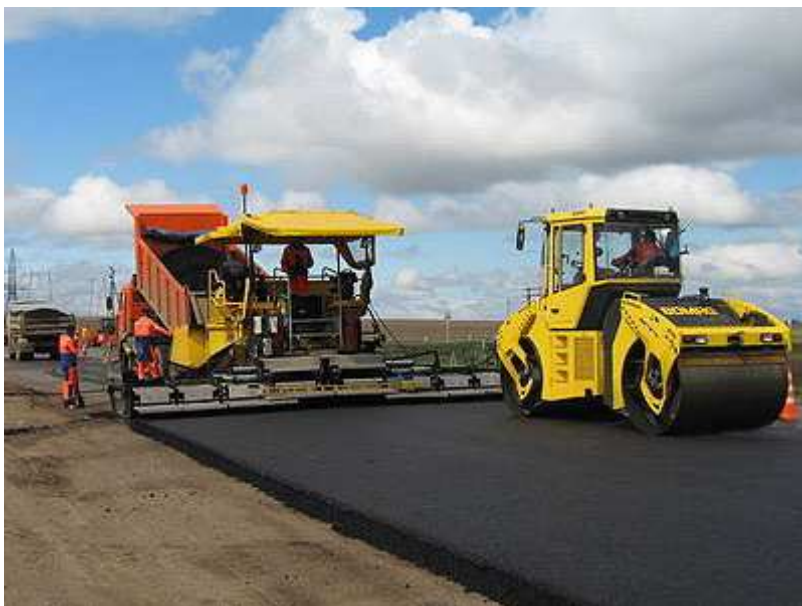
Рис. 6.1. Технологический процесс строительства покрытия нежесткого типа
