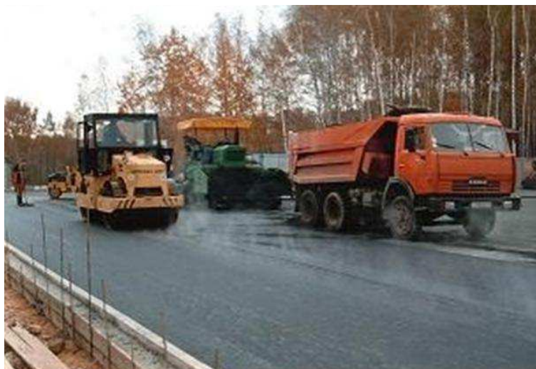
Рис. 6.33. Укладка асфальтобетонной смеси одним асфальтоукладчиком со смещением полос дорожного покрытия
