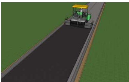
Рис. 5.5. Укладка горячей асфальтобетонной смеси одним асфальтоукладчиком при строительстве автомобильной дороги с увеличенной шириной полосы движения
