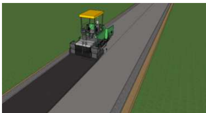
Рис. 5.6. Укладка части покрытия одним асфальтоукладчиком
