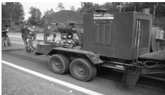
Рис. 1.5. Установка MAGNUM для ямочного ремонта струйно-инъекционным методом производства компании Crafco
