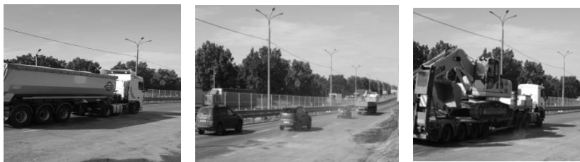
Рис. 6.15. Транспортный поток на участке ремонта покрытия
