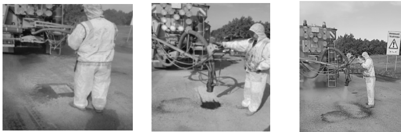
Рис. 6.13. Подготовка места к ремонту выбоины и заполнение выбоины смесью
