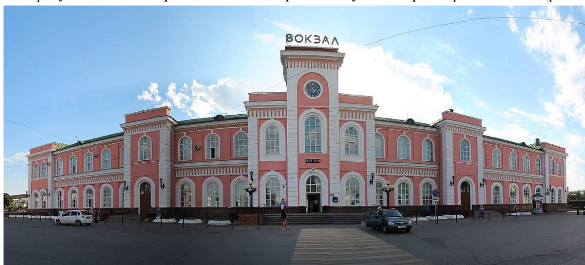
Рис. 3. Вид железнодорожного вокзала со стороны города Тамбова [8]
