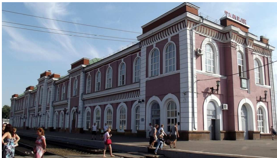
Рис. 4. Вид железнодорожного вокзала со стороны железнодорожных путей [9]
