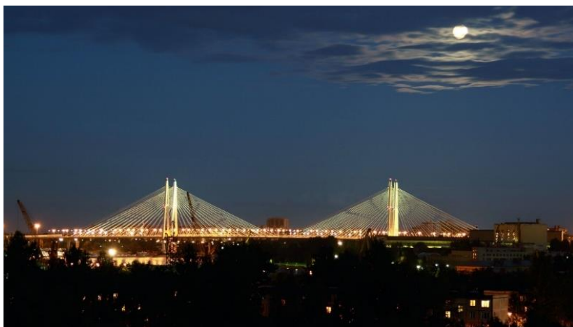
Рис. Б.6. Вид на Большой обуховский мост
