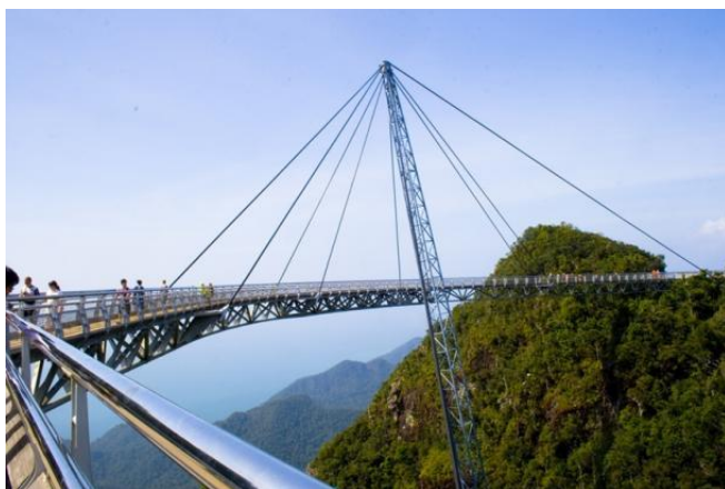
Рис. Б.9. Опора небесного моста
