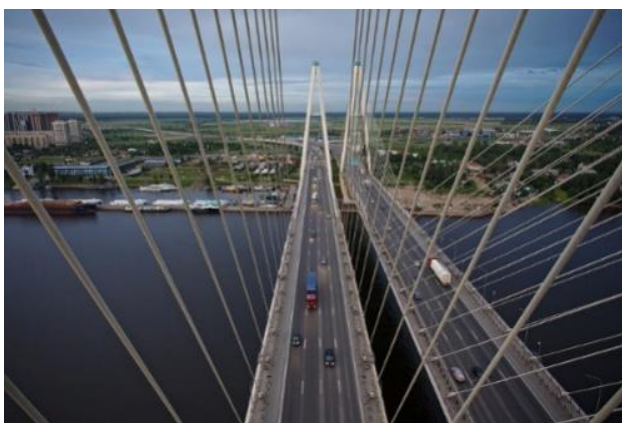
Рис. Б.7. Вид с пилона моста на дорожное полотно и ванты
