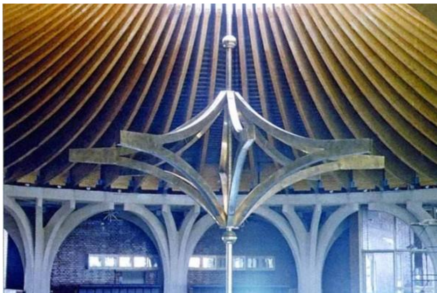
Рис. В.7. Часть клеёных деревянных конструкций центра «Липки»
