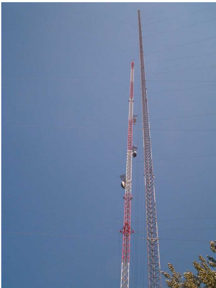
Рис. Г.6. KRDK-TV mast
